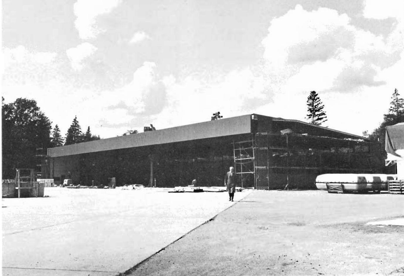
Flygverkstaden vid F12 får inte något ökat utrymme men nytt tak och nytt golv har man fått. Här en bild från förstärkningsarbetena.
